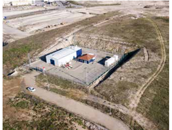
Doğal gaz istasyonu
